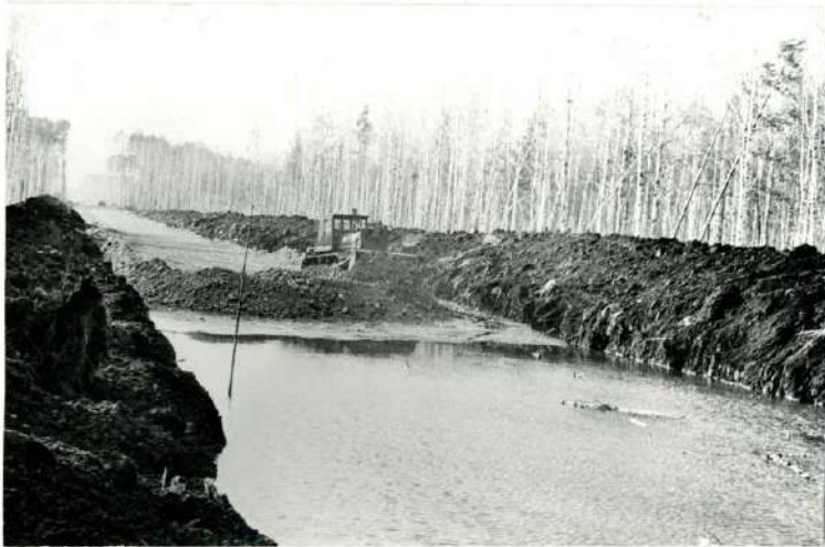
Строительство дороги до поселка Рефтинского
